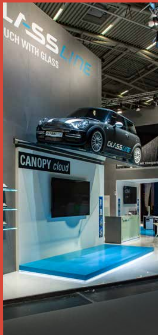
Geprüft von der Glasprüfstelle Würzburg: Konstruktionen wie die spektakuläre Messeinszenierung der Firma Glassline aus Adelsheim, zwischen Würzburg und Heilbronn gelegen. Die Vordach-Glasplatte hat eine Ausladung von 1,90 m und der Mini ein Gewicht von 900 kg.
